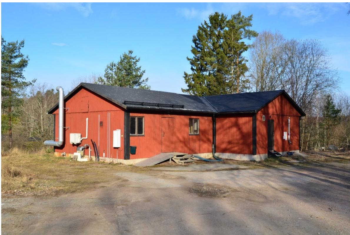
Figur 4.1. Flintavik reningsverk. Foto: Michael Kämpenber.
